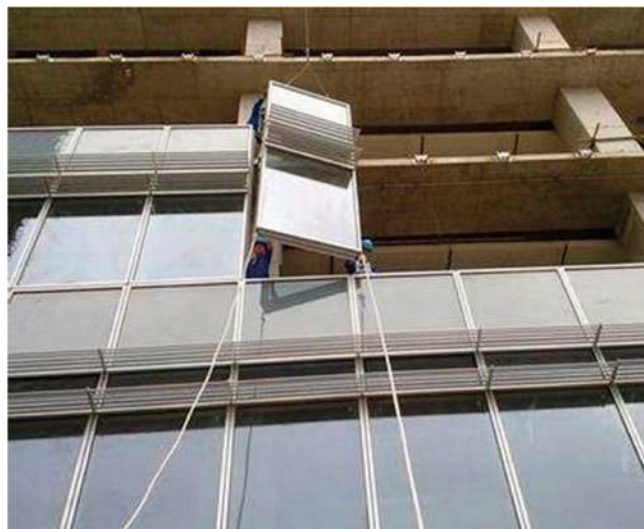
单元式玻璃幕墙安装方式示意图
