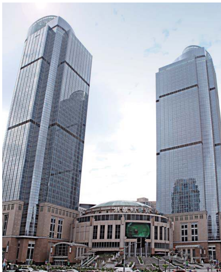
港汇恒隆广场
