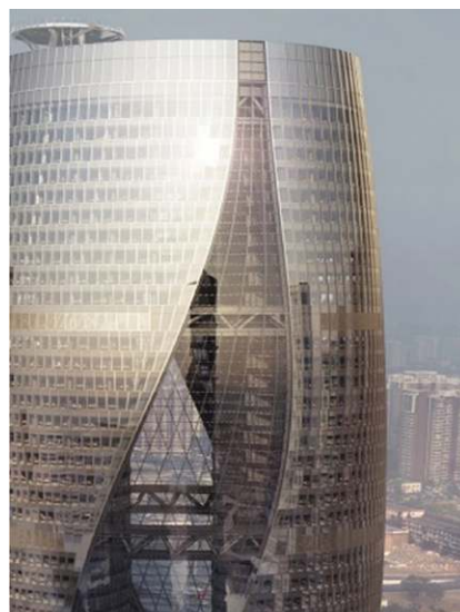
鱼鳞状幕墙和点式幕墙
